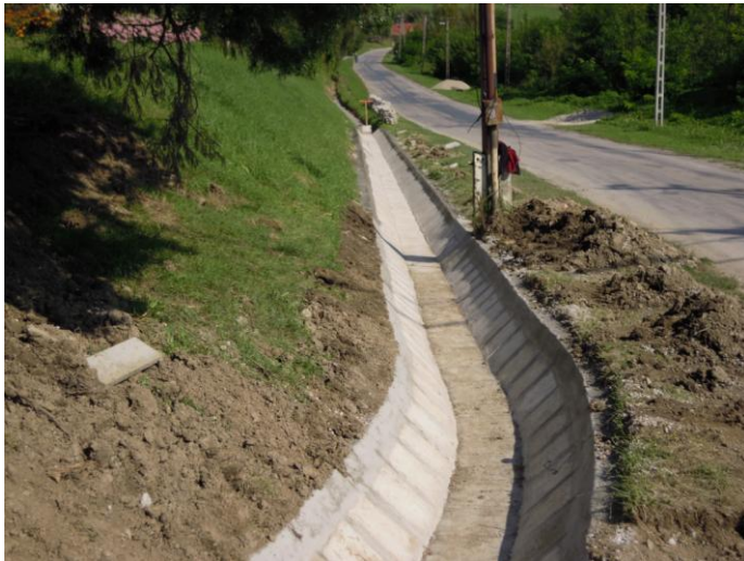
Készül a vízelvezető árok
